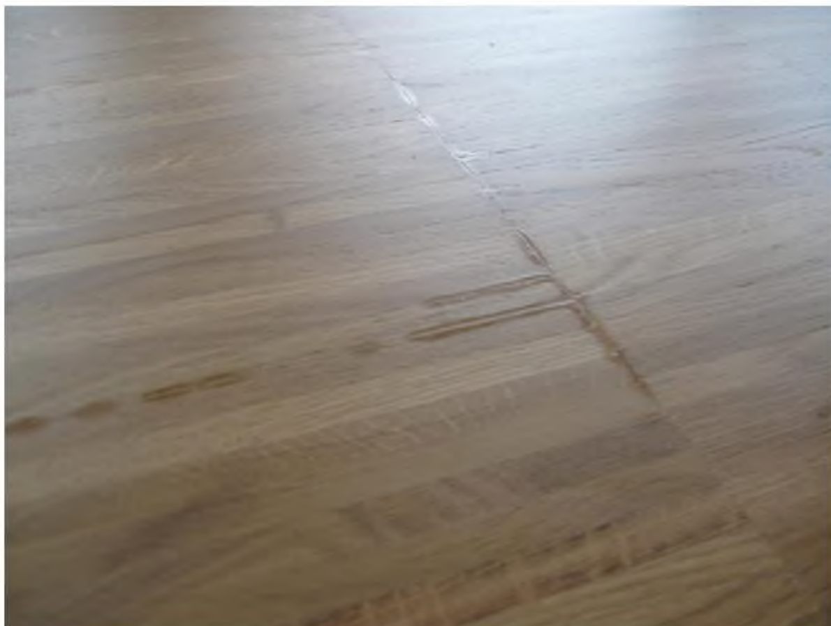
Obrázek: Lesklé spáry při lakování matným olejo–syntetickým lakem
