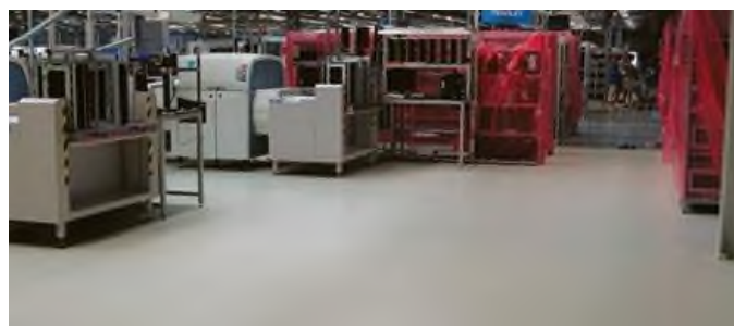
Po ESD renovaci
