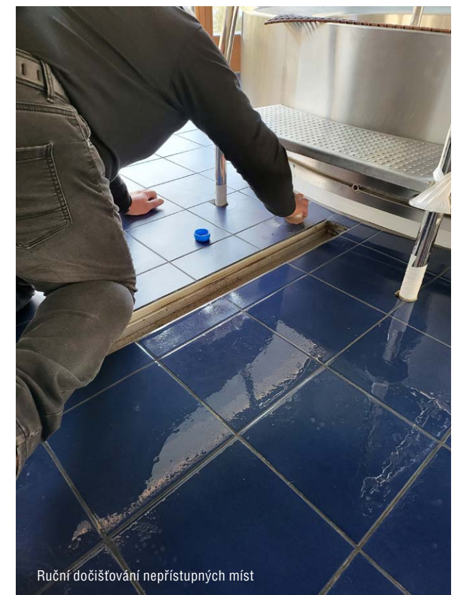
Keramická dlažba po transparentním lakování
