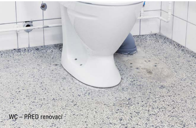
Nemocnice – PO renovaci
