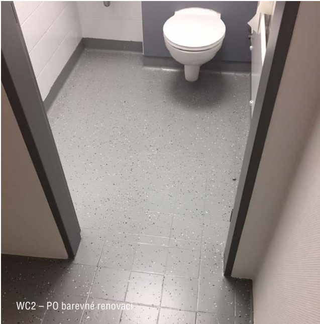
WC2 – PŘED renovací
